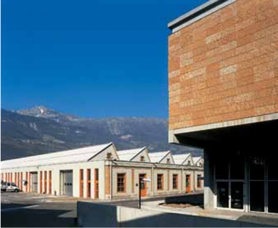
5- Les bâtiments récupérés et une partie du nouveau bâtiment ajouté
