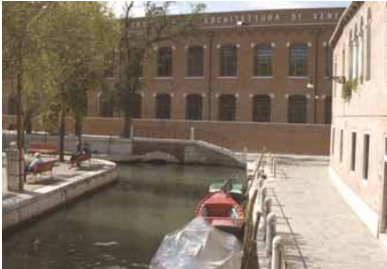
6- La façade d'entrée après la récupération
