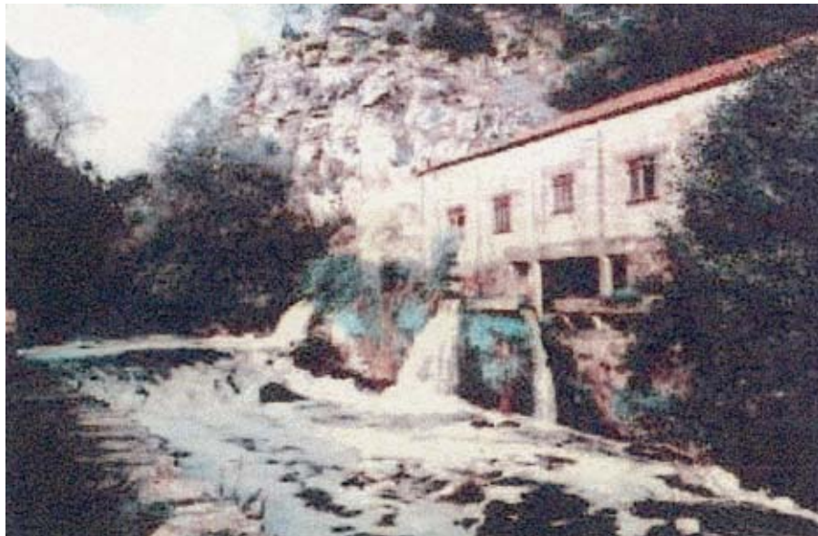
2. Vue du bâtiment principal
