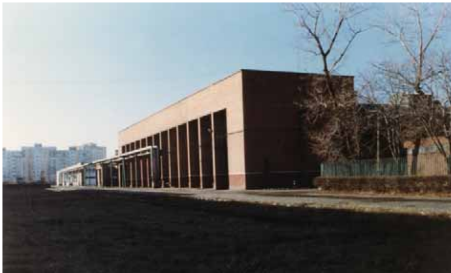
Fig.4 Vue extérieure du bâtiment principal
