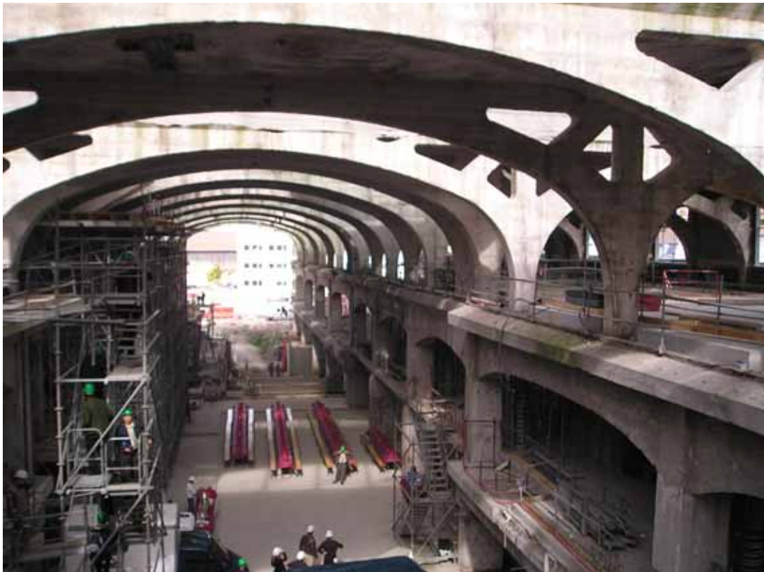
Fig. 7 Chantier de reconversion d'une travée (2005)
