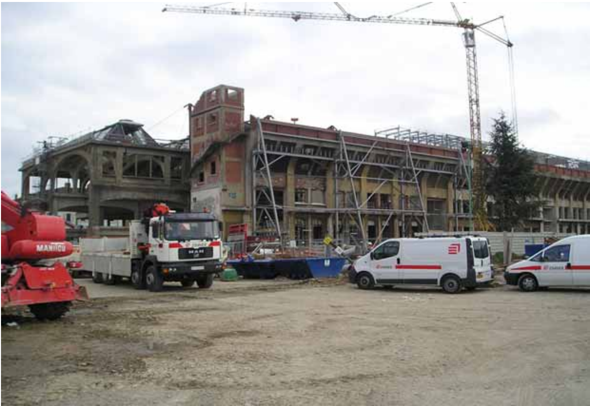
Fig. 6 Vue du bâtiment et du chantier (2005)
