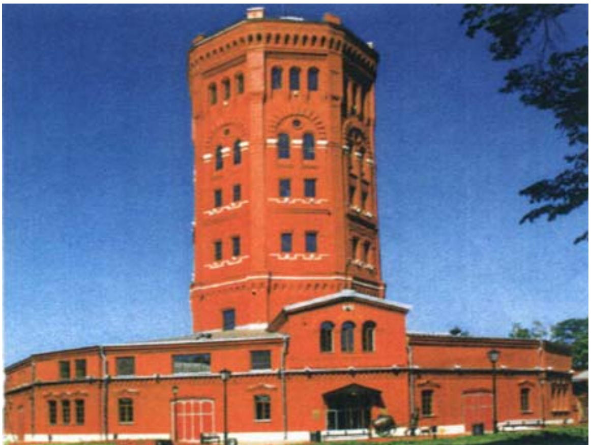
Fig.5 La tour après la reconversion
