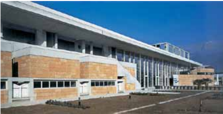
6- Il fronte est del nuovo edificio
