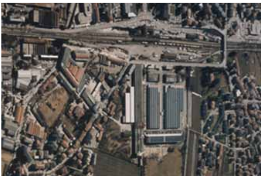
2- Veduta aerea della ex- Pirelli prima della riconversione (1990)
