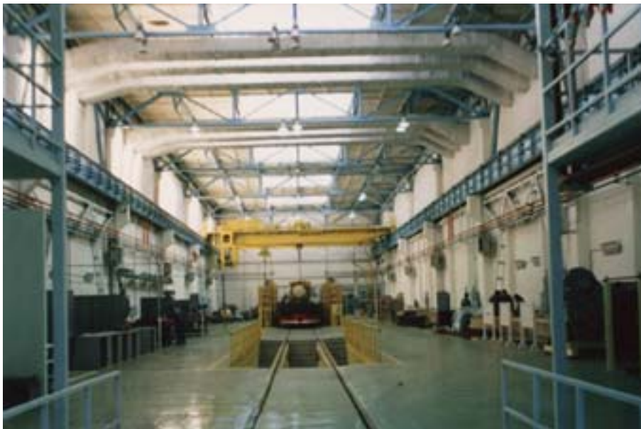
Fig. 5: Reparto di montaggio/riparazione
