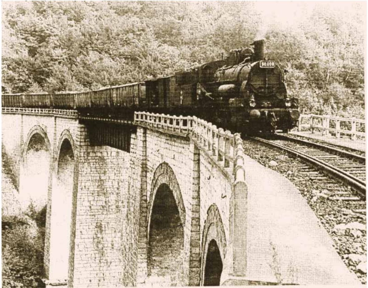
Fig.3 Locomotiva a vapore sul viadotto Schlucht
