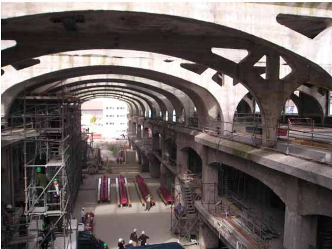
Fig. 7 Cantiere di riconversione di una campata (2005)
