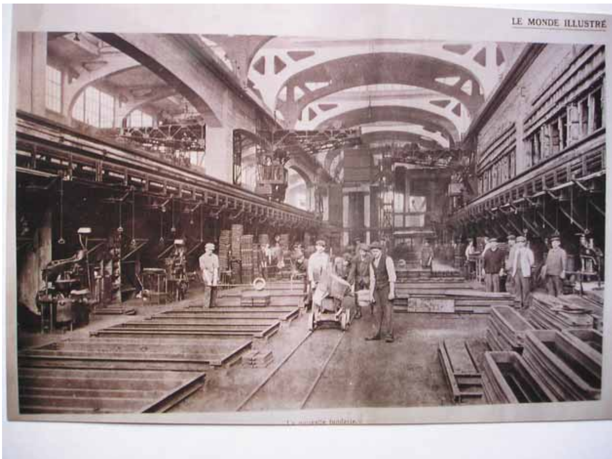
Fig.5 Interno della Fonderia: impianti della colata e della formatura
