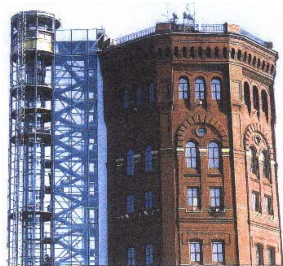
Fig.3 Vista laterale della torre
