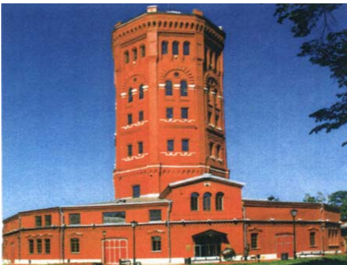
Fig.5 La torre dopo la riconversione
