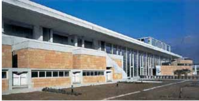
6- Frente do novo edifício
