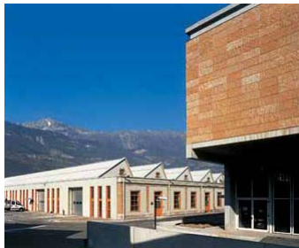
5- Os edifícios recuperados e uma parte do novo acrescentado
