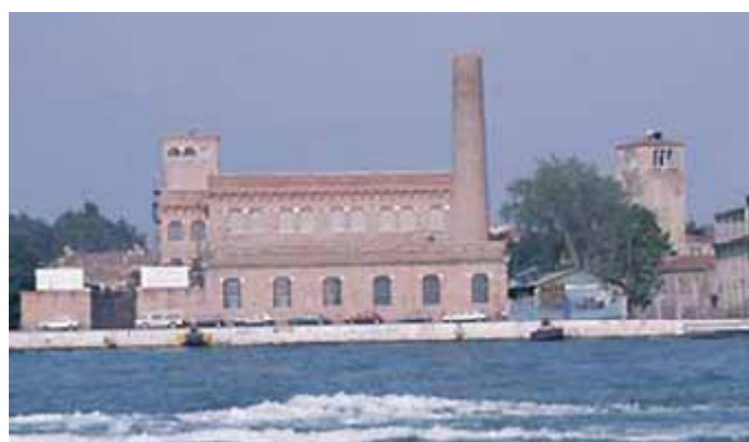
7- Vista de conjunto após a recuperação
