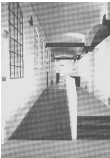
5-O interior após a recuperação
