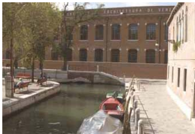
6- A fachada da entrada após a recuperação
