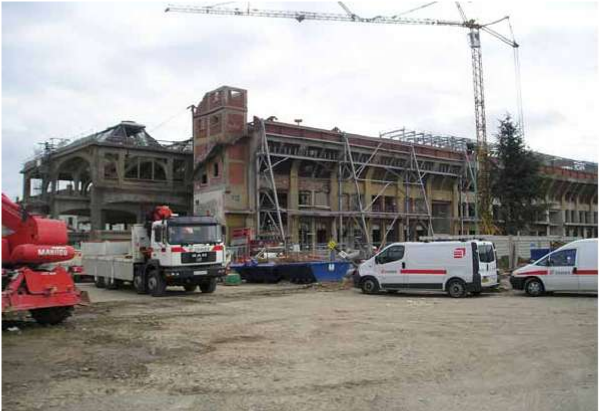
Fig. 6 – Vista sobre o edifício e estaleiro.
