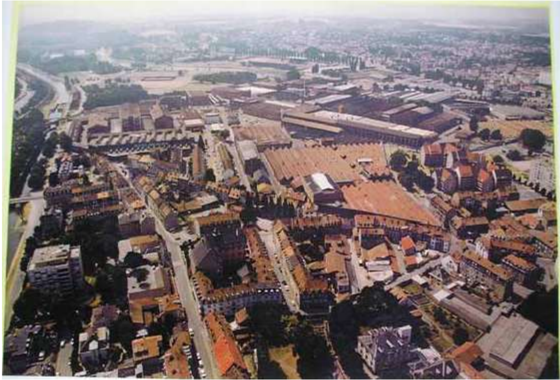
Fig. 4 – Vista do sítio industrial da SACM e do quarteirão da fundição (cerca de 1985).
