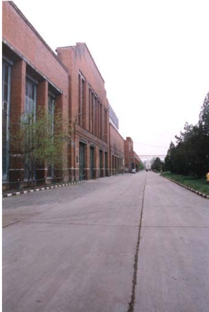
Fig. 4: Vederea exterioară a clădirii principale
