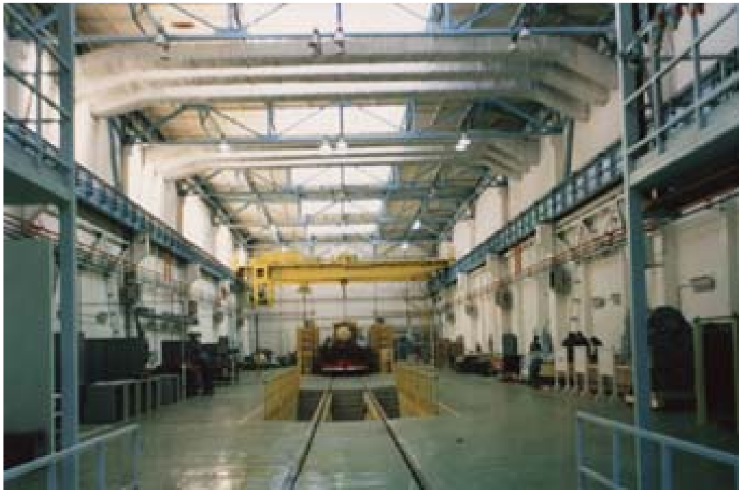
Fig. 5: Hala de montare / reparații
