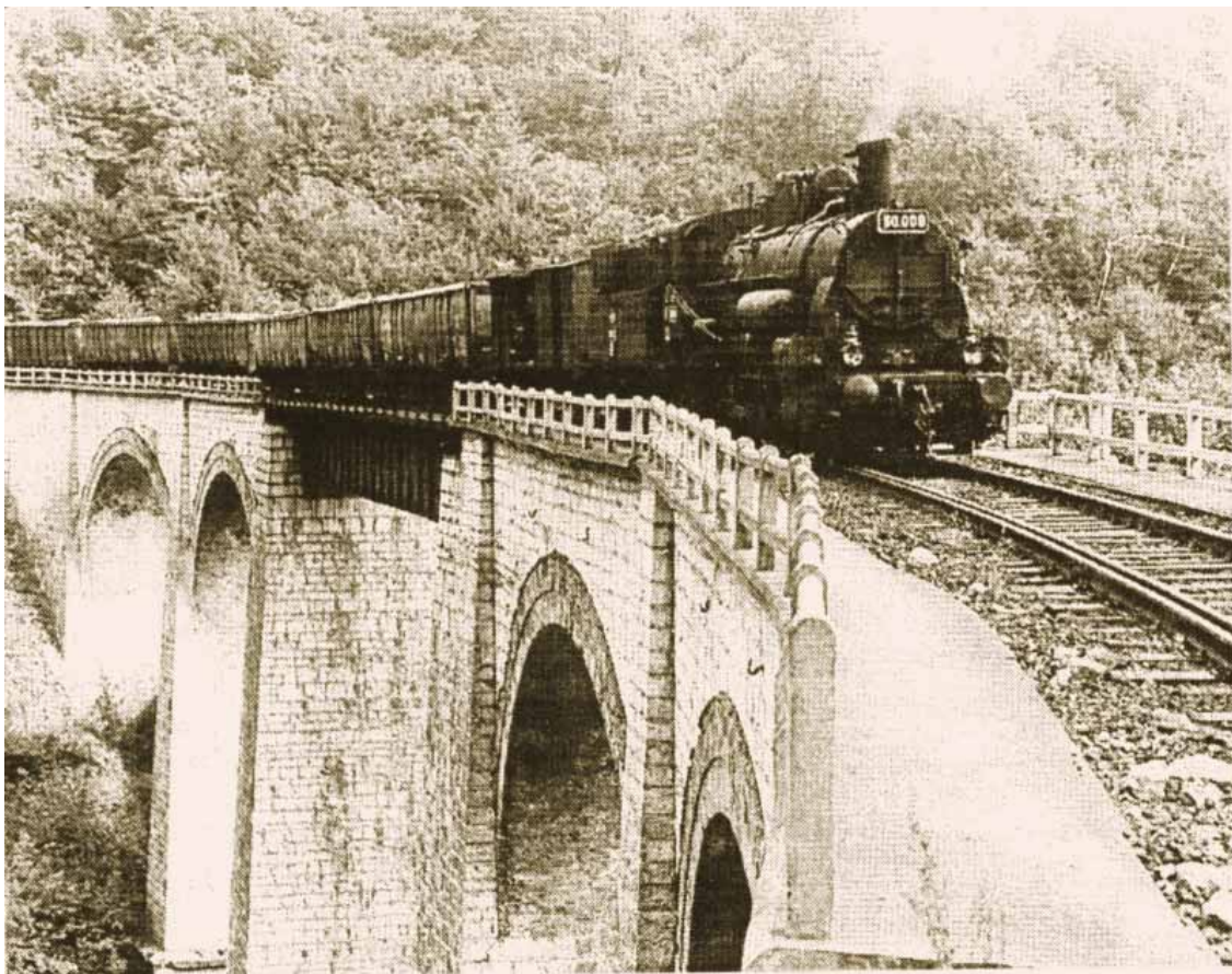
Fig.3 Lomotiva cu aburi pe viaductul Schlucht
