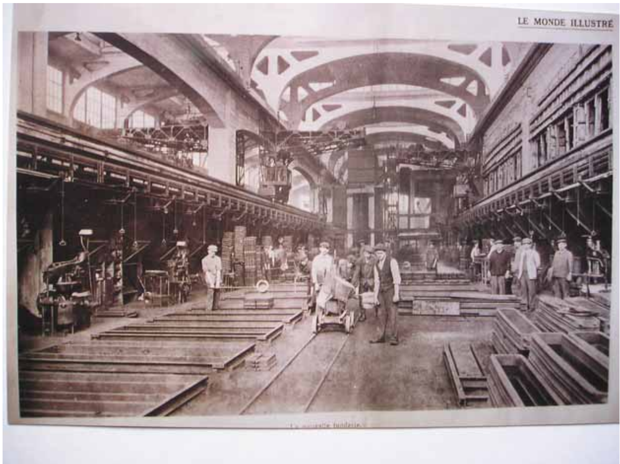
Fig. 5 Interiorul Turnăroiei: instalații de turnare și de topire
