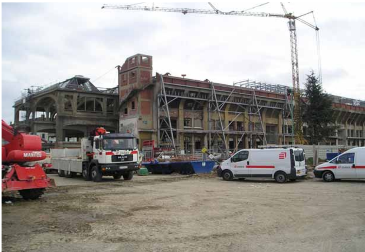
Fig. 6 Vedere asupra construcției și șantierului (2005)
