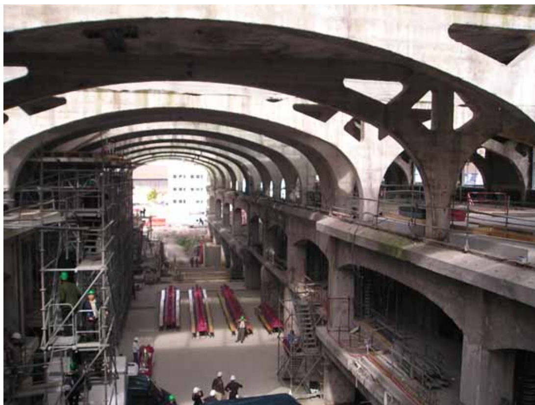
Fig. 7 Șantierul reconversiei unei travei (2005)
