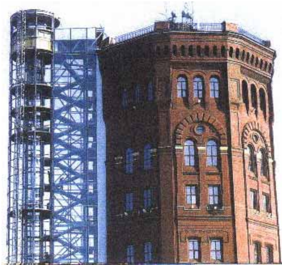
Fig.3 Vedere laterală a turnului
